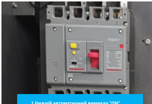
1. Нижній автоматичний вимикач "ON"
