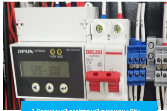
2. Проміжний повітряний вимикач «ON»
